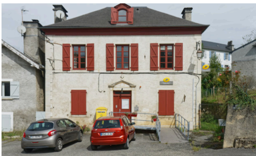
Le bâtiment en septembre 2024, un accès pour personnes à mobilité réduite a été aménagé en 2020.
